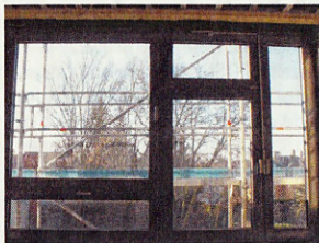
Die neuen Fenster bestehen aus hoch- und querformatigen Elementen.
