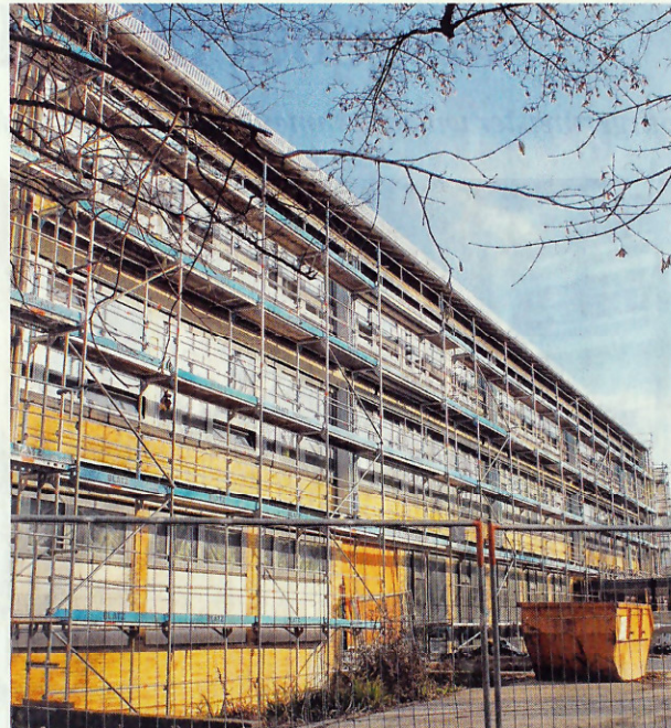
Das Gebäude II der Schillerschule ist seit Monaten eingerüstet. Die Fenster sind bereits ausgetauscht. Die Klinkerfassade wird mit Harzkompositplatten gedämmt.
