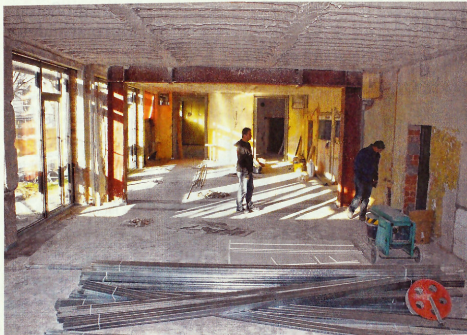
Für die Mensa im Erdgeschoss wurde die Wand zwischen zwei ehemaligen Klassenzimmern herausgebrochen. Im dritten ehemaligen Klassenraum (hinten) wird die Küche eingerichtet. Die Fensterfront zum Spielplatz (links) ist raumhoch. Fotos: Peter Hohl
